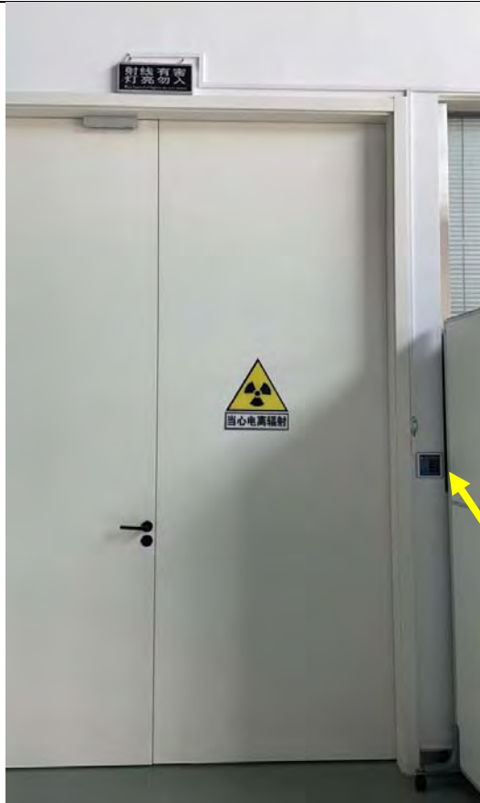
检测实验室入口门禁系统
